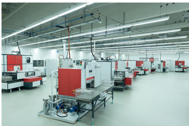
► Centre d'applications et d'essais clients pour la qualification d'un nouveau process
