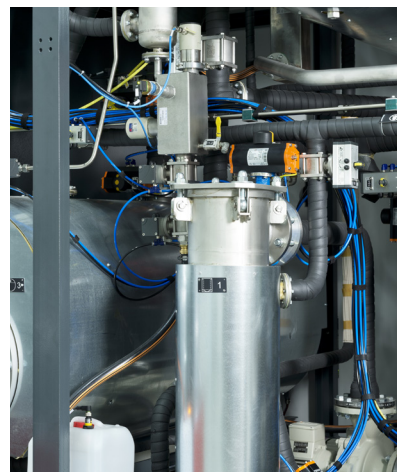
Contrôle et séchage des filtres
